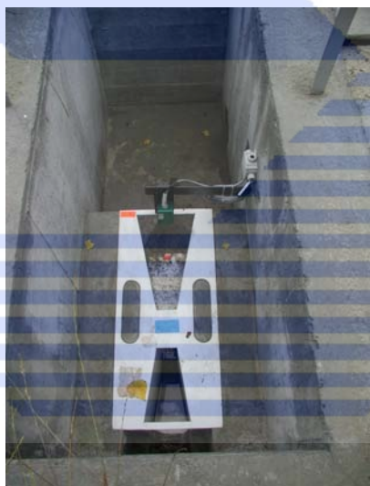
Obr. 4.1.4.2. Instalace Parshallova žlabu v otevřeném kanálu
